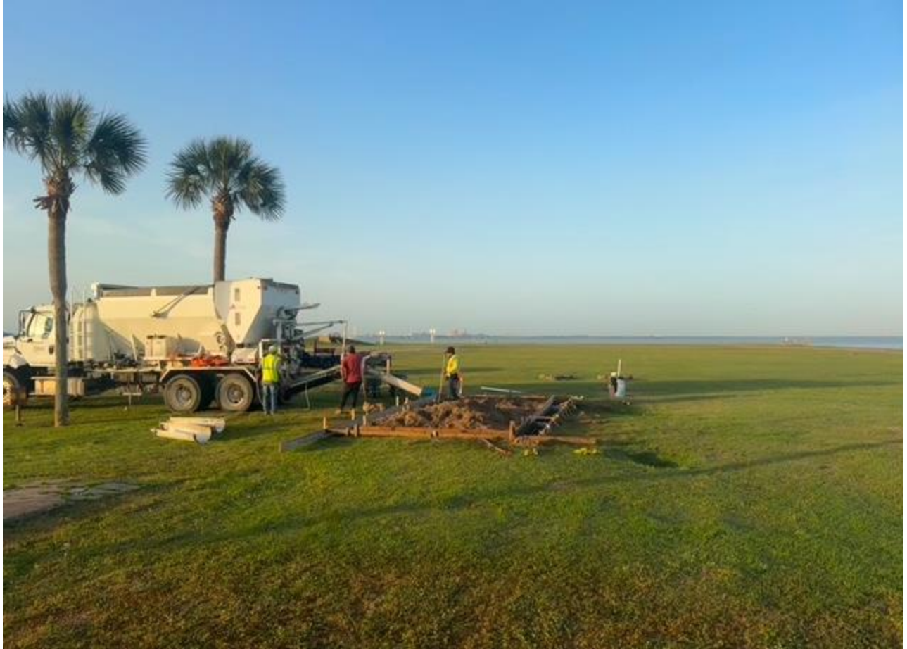
Concrete slab pour
